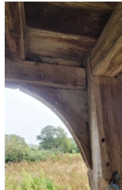
Arche et pile
