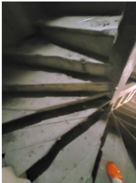
Escalier dans tour Nord-Est
